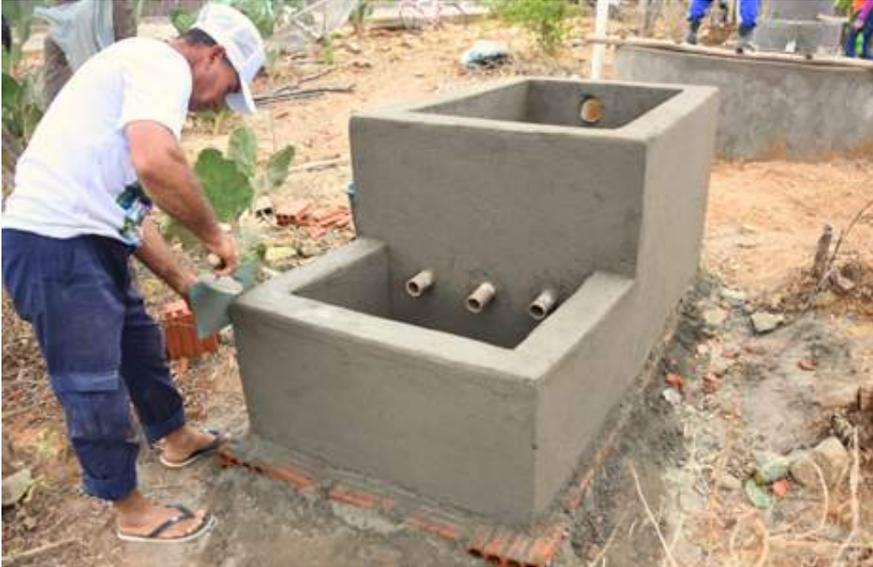
Figura 25: Caixa de descarga sendo concluída
