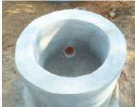
Figura 23 - Caixa de carga construída
