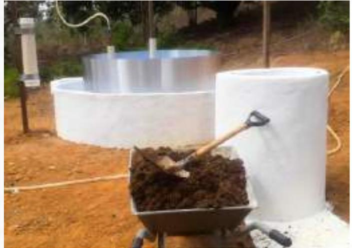
Figura 35: Início do primeiro abastecimento do biodigestor
