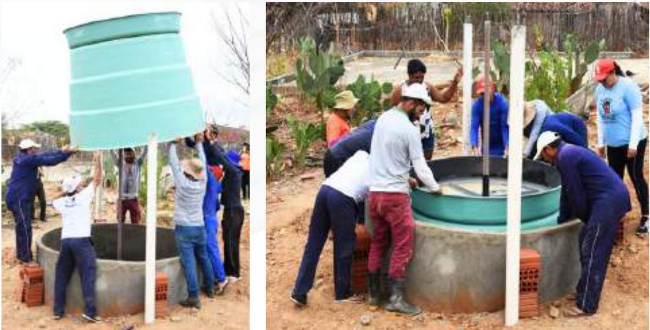
Figura 28: Câmara de armazenamento de biogás instalada
